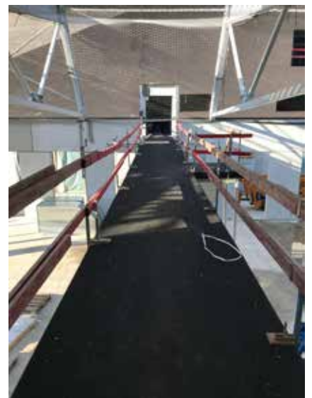
Via deze passerelle kun je van de sporthaltribune naar de tribune van het zwembad. Je loopt over de nieuwe sportbar.
